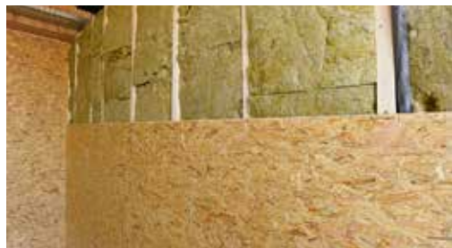
„Die Vorteile des Holzrahmenbaus liegen bei seinen geringen Bauteildicken bei guter Trag- und Wärmedämmfähigkeit und seinem noch höheren Vorfertigungsgrad“, so Markus Obermüller.
