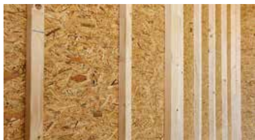
Für Wandbauteile mit aussteifender Funktion wurde die Dicke der SterlingOSB-Platten auf 22 mm erhöht.
