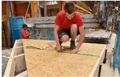
Für die Vorfertigung wurden 15 mm SterlingOSB-Großformatplatten von West Fraser in den Abmessungen 2,50 x 5,0 m genutzt, die für die dampfbremsende und luftdichte Ebene sorgen.
