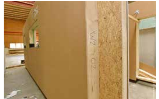
Für die Vorfertigung wurden 15 mm SterlingOSB-Großformatplatten von West Fraser in den Abmessungen 2,50 x 5,0 m genutzt, die für die dampfbremsende und luftdichte Ebene sorgen.
